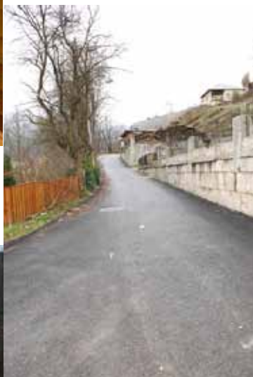
Zahlreiche Straßen wurden saniert, unter anderem auch der Furtherweg.
